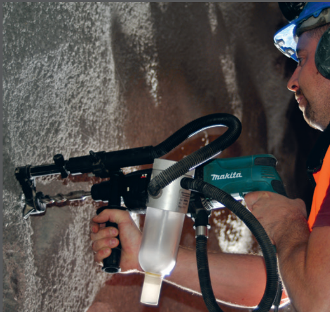
Bohrmehlentnahme am Objekt
